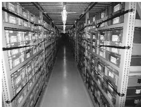
落下防止ベルト設置状況
