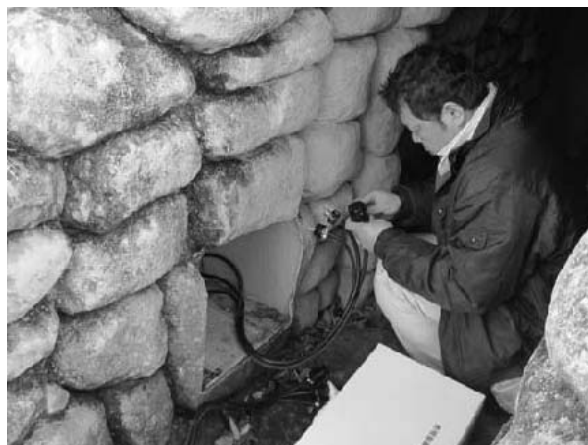
前方後円墳内部照明制御盤修繕
