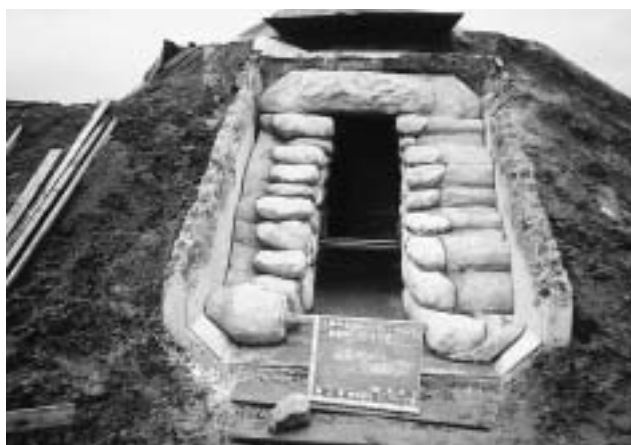
古墳石室の工事
