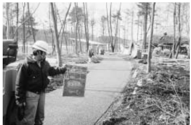
園路の舗装工事
