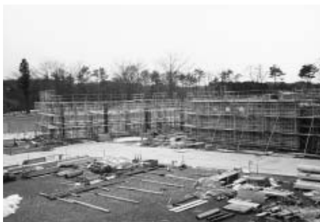
建築工事（平成12年3月）
