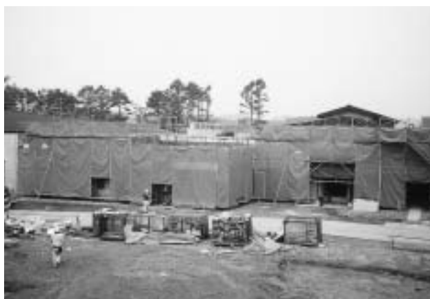
建築工事（平成12年7月）
