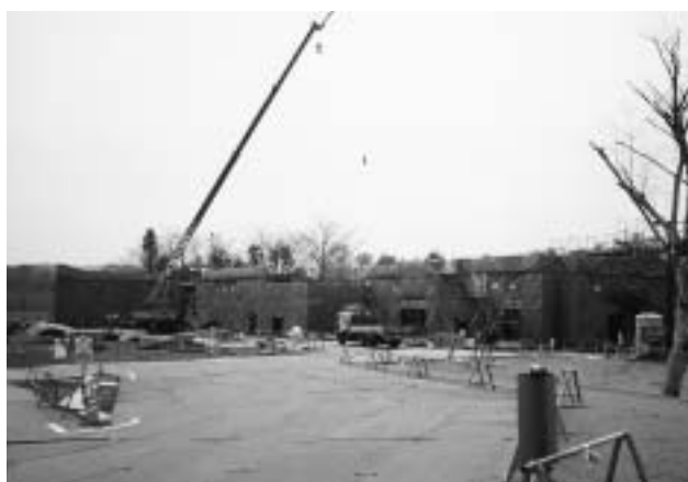
建築工事（平成12年4月）
