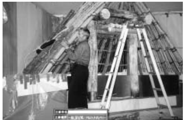
屋内展示工事のようす
