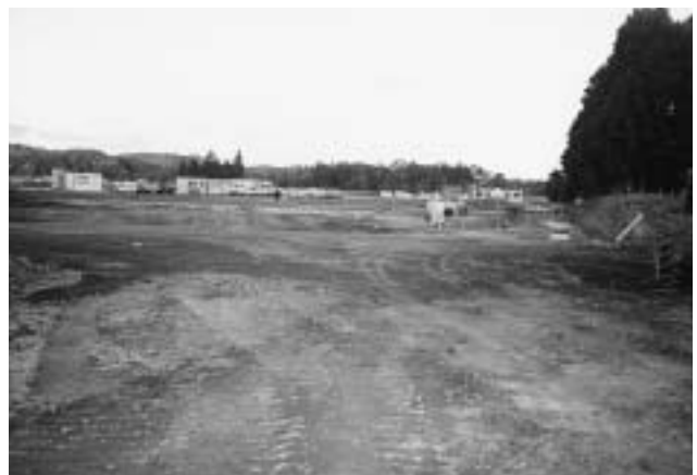
造成中の敷地(2)
