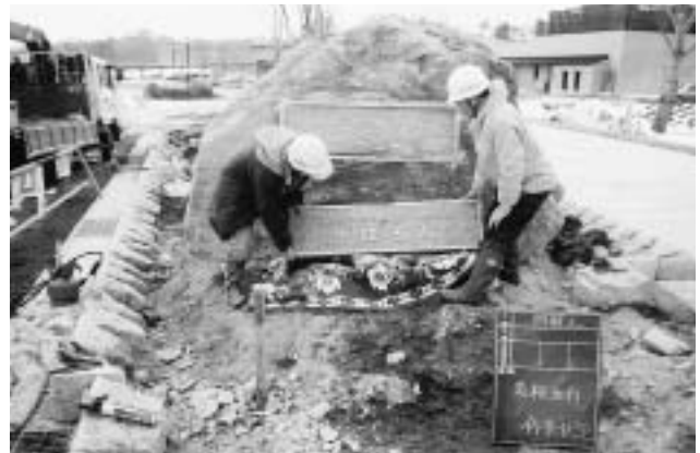
銘板の取り付け工事
