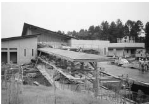
建築工事（平成12年8月）
