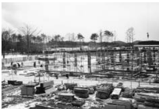
建築工事（平成12年2月）
