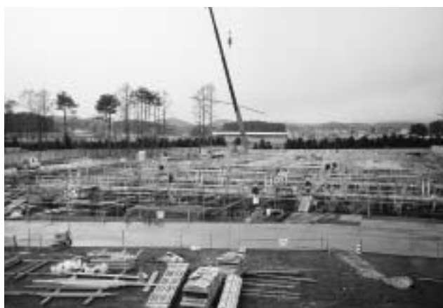
建築工事（平成11年12月）
