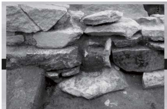
12 Ⅲ区3号平場1号桁形礎石 柱の礎石、石垣高は現況で最大80cm。石の積み方は同じ？
