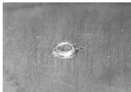
写真30 固定されたパイプ（裏側）
