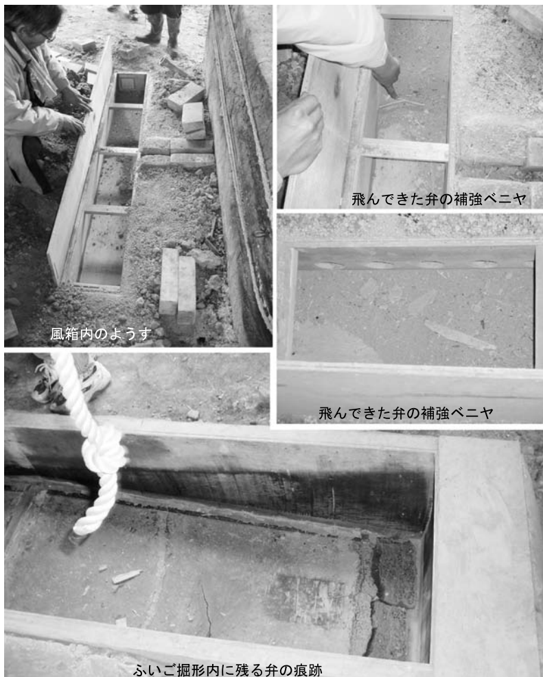
図 12 空気取り入れ弁と送風孔のズレと風箱内のようにす
