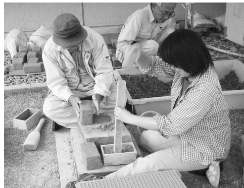
ブロックの木枠(内寸：幅11×長19×深7.5cm)
